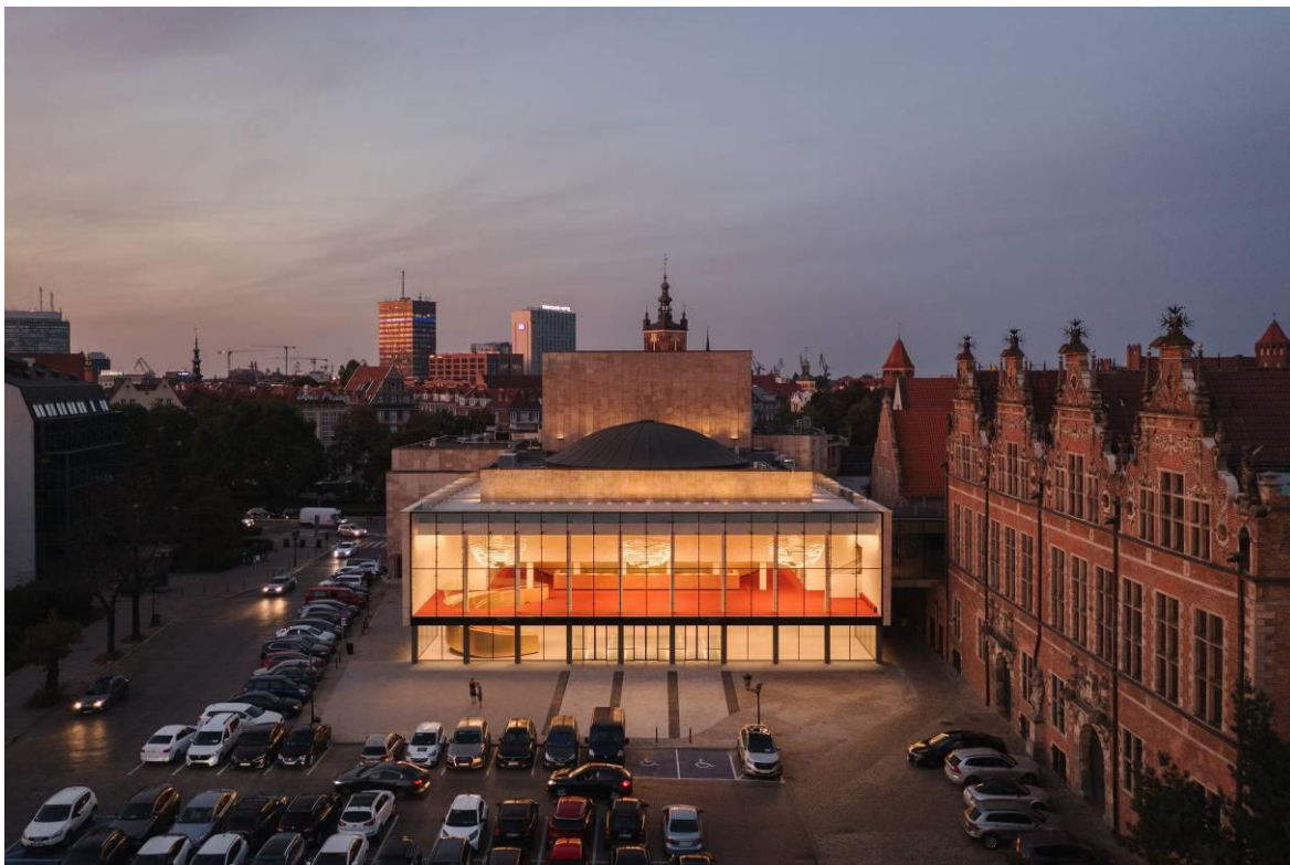
il. 18. Widok siedziby Teatru Wybrzeże od strony Targu Węglowego po przebudowie
