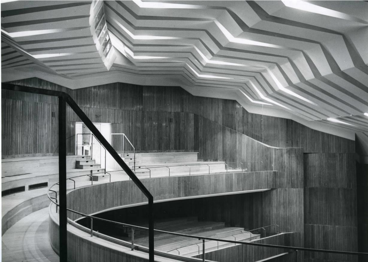
il. 16. Sala widowni (rok 1966 – w trakcie realizacji)
