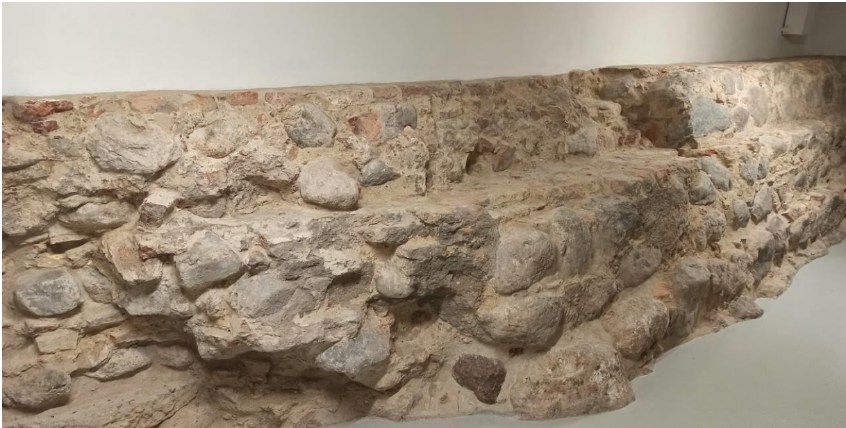
il.29. Fragment zachowanych fundamentów pierwszego budynku teatralnego na Targu Węglowym w Gdańsku, według projektu architekta Carla Samuela Helda
