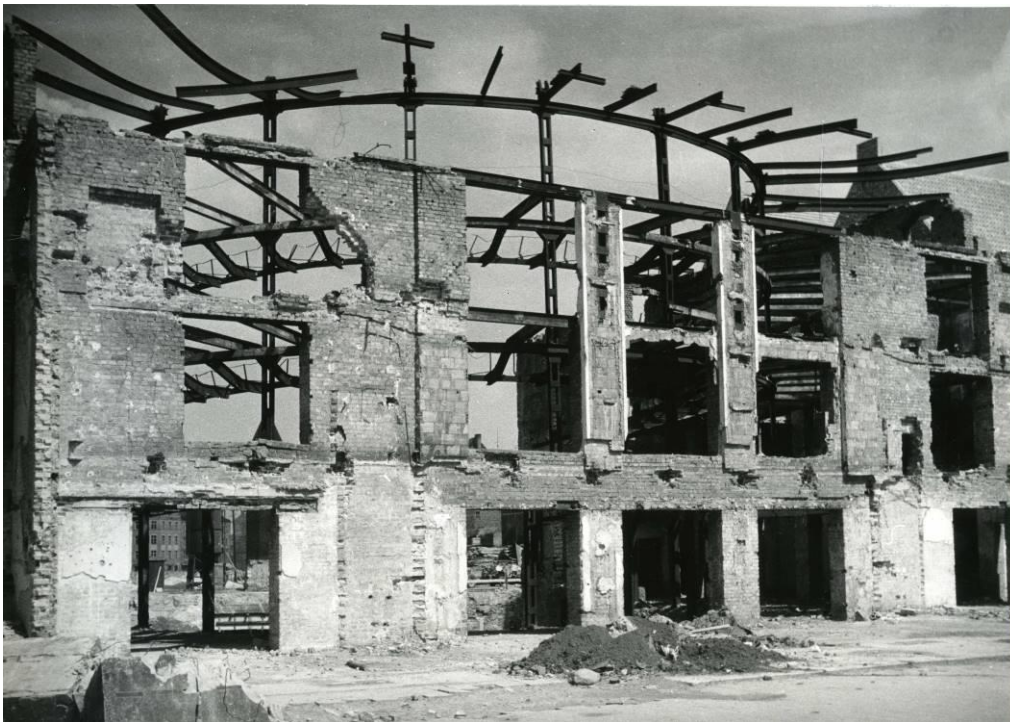
il. 5. Fragment zniszczonej konstrukcji sali widowni teatru na Targu Węglowym (po 1945 roku)
