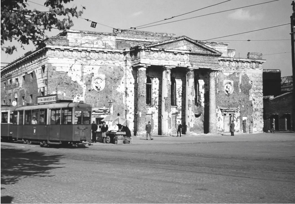
il. 4. Widok zniszczonego budynku teatru na Targu Węglowym (po 1945 roku)
