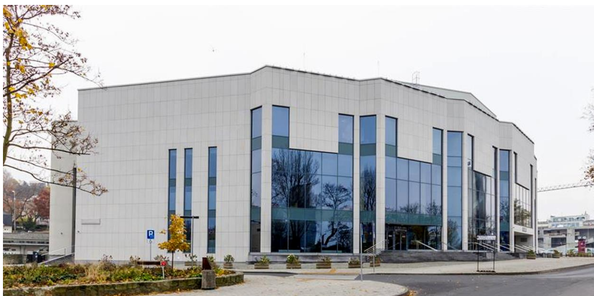
il. 8. Widok elewacji zachodniej
