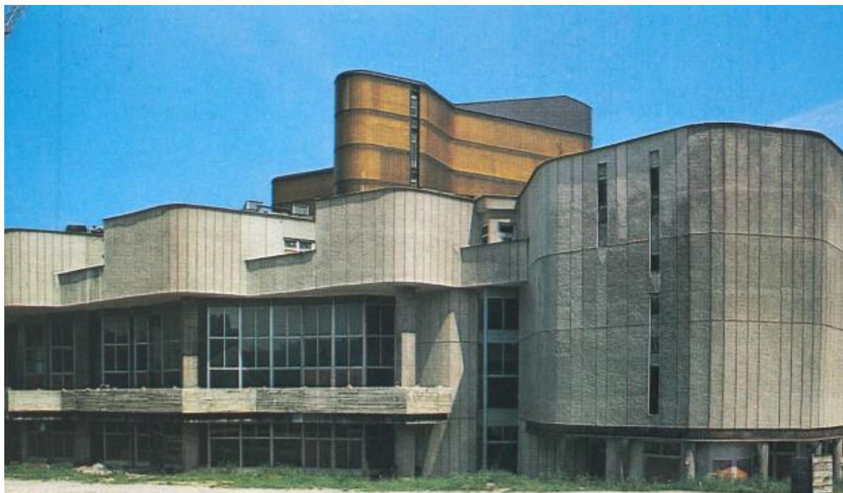
il. 4. Fragment elewacji wschodniej (widoczna dominanta w postaci wieży sznurowni, która została pokryta płytkami odbijającymi światło słoneczne)
