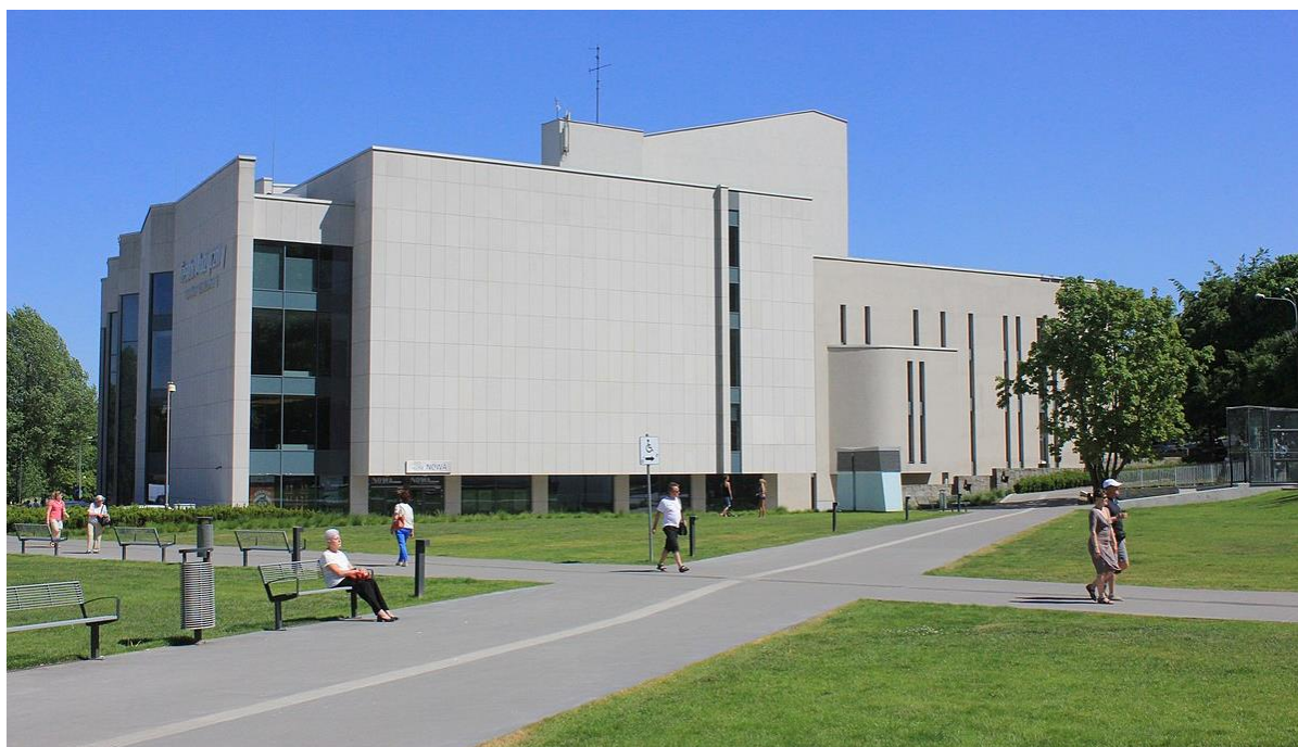
il. 11. Widok elewacji wschodniej
