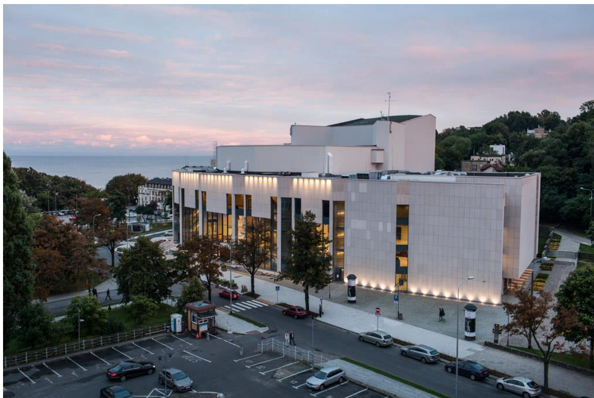
il. 10. Widok elewacji południowo-wschodniej
