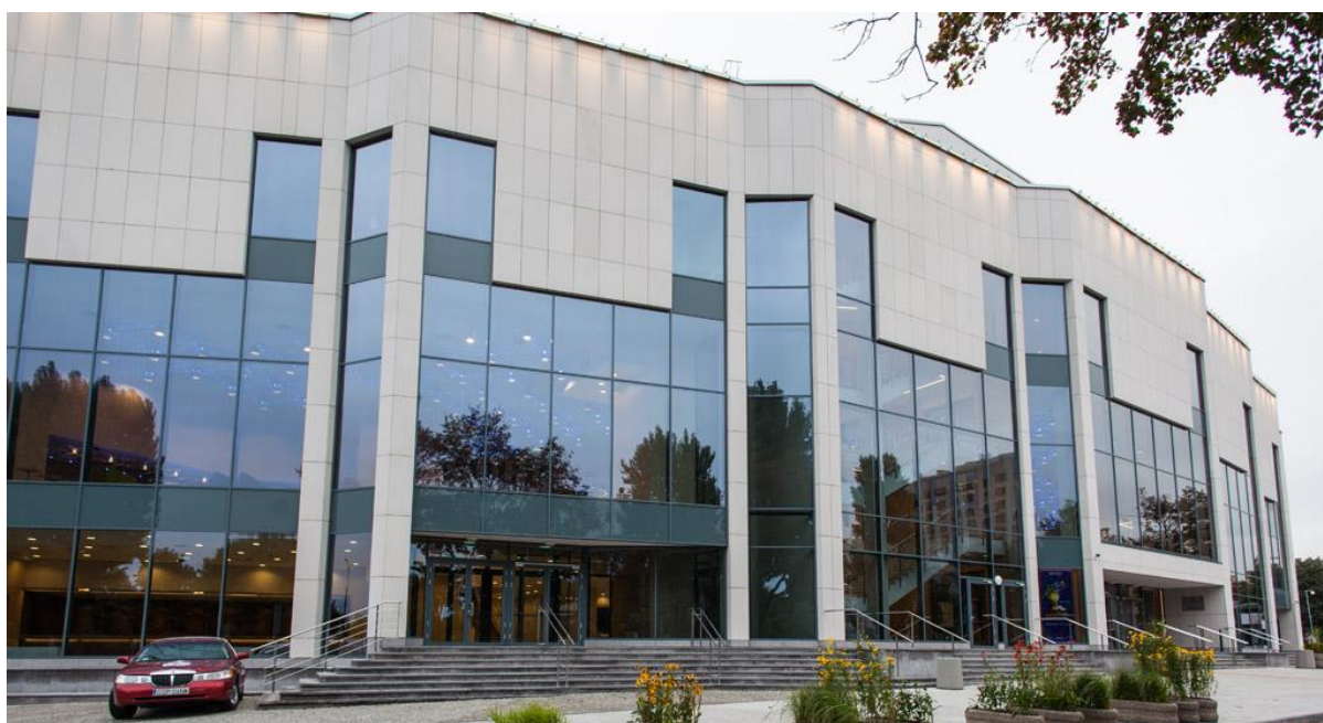
il. 9. Fragment elewacji południowej
