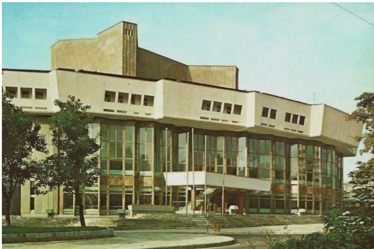
il. 3. Widok reprezentacyjnej elewacji gmachu od strony południowej
